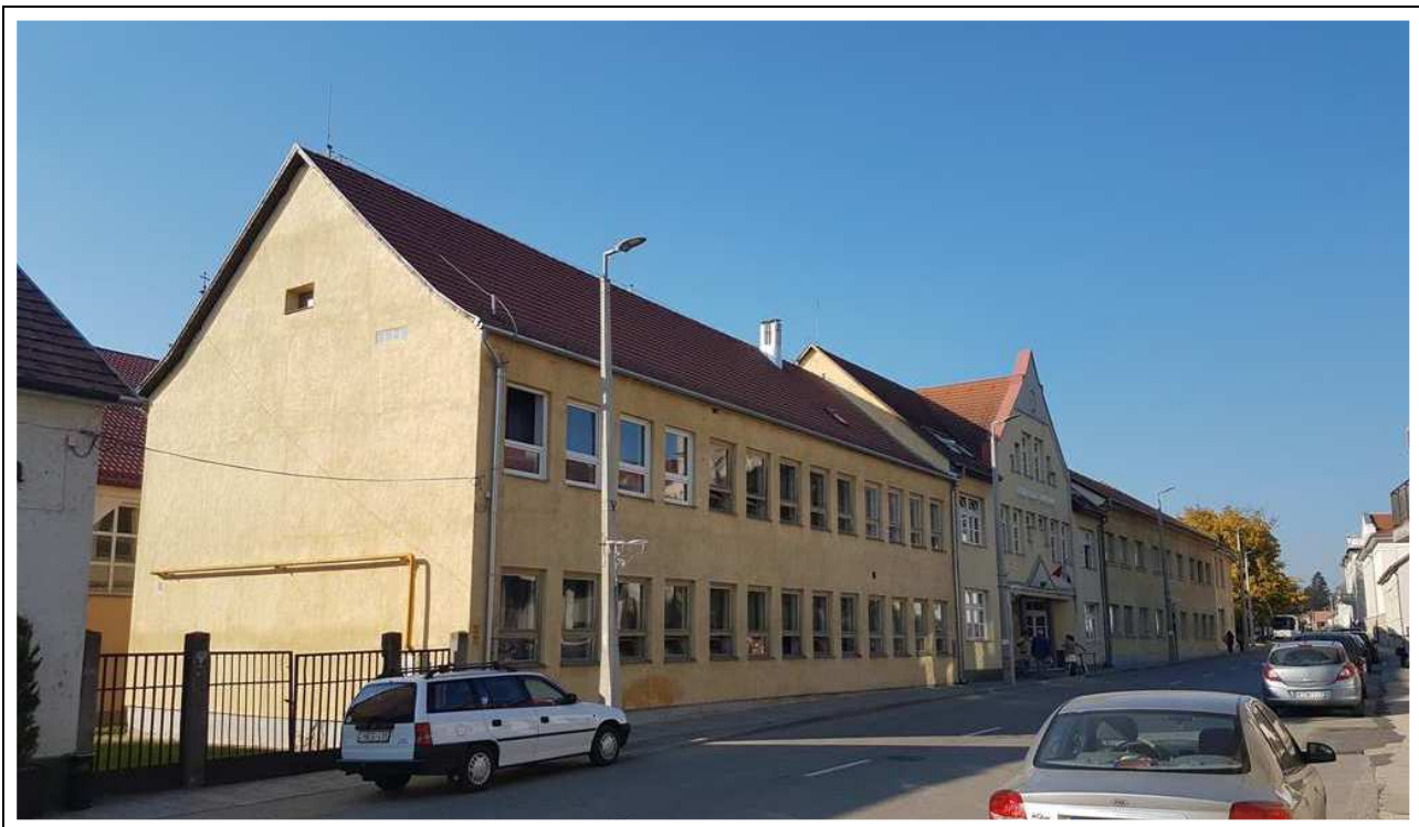
A Tolnai Lajos Gimnázium új főépülete.
